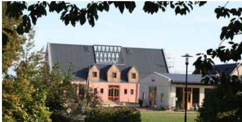
"Wenn wir bleiben, brauchen wir eine Schule": Hier das umgebaute Schulgebäude in Lüchow. Foto: Privat
